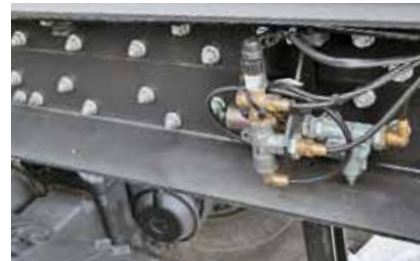
Кронштейны и усилители рамы крепятся на высокопрочных болтах
