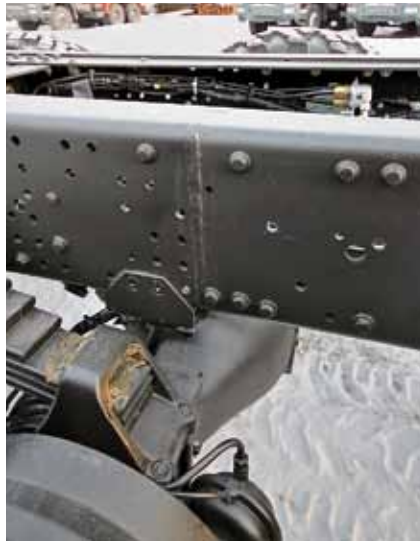
В этом месте лонжерон рамы сварен, но внутри установлены усилители
